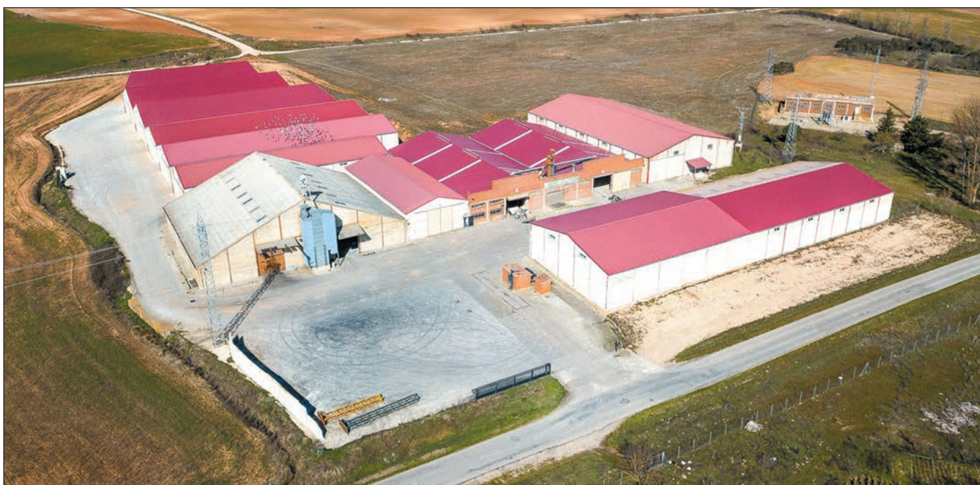
Instalaciones de la cooperativa Padre Flórez en Villadiego (Burgos).
